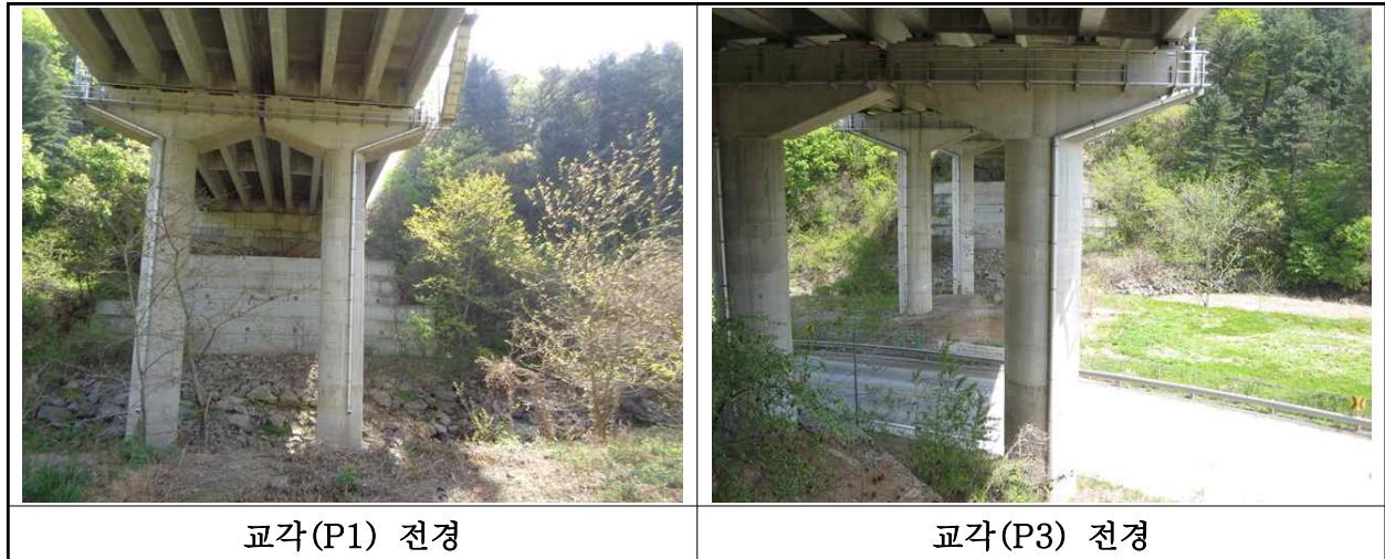
【사진 1.3.10】 교각 전경
