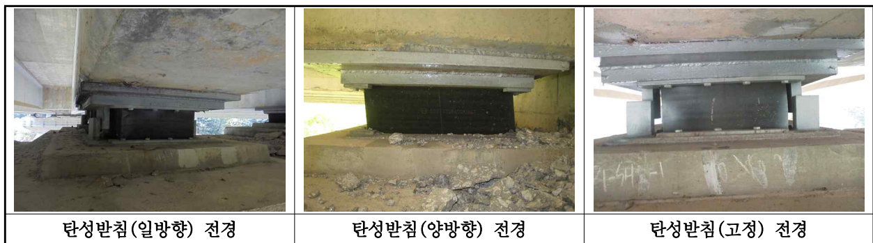
【사진 1.3.12】 교량받침 전경
