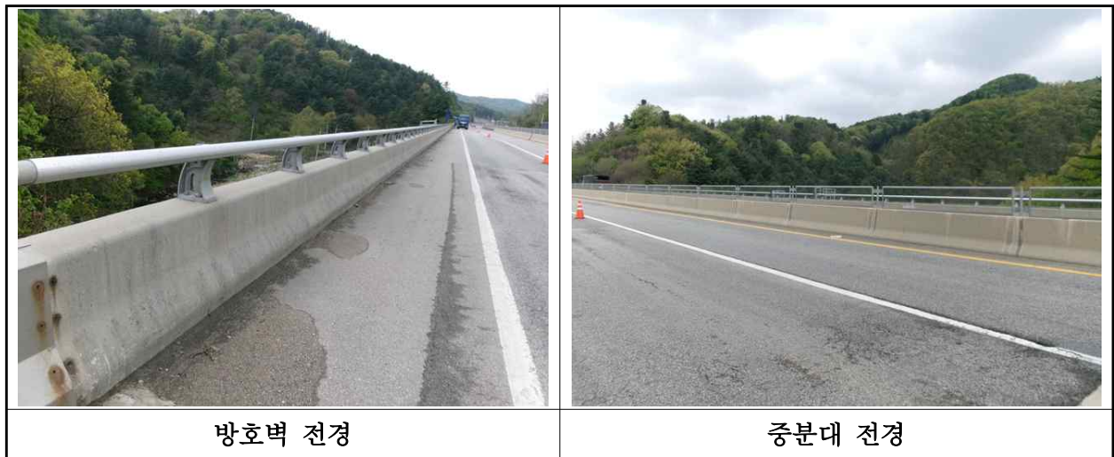
【사진 1.3.23】 방호벽 및 중앙분리대 전경
