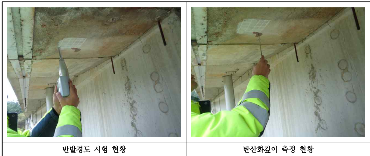
【사진 1.4.1】 콘크리트 내구성조사 현황
