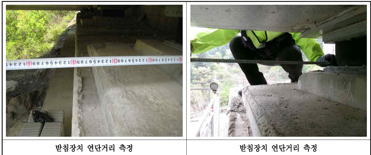
【사진 1.3.14】 교량받침장치 연단거리측정
