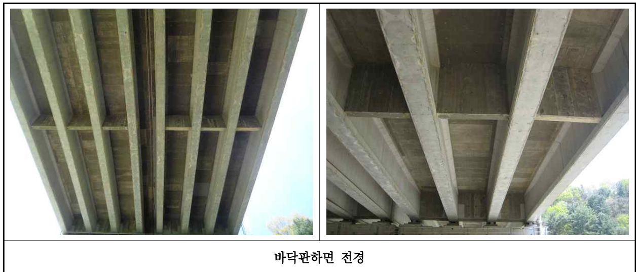
【사진 1.3.2】 바닥판하면 전경
