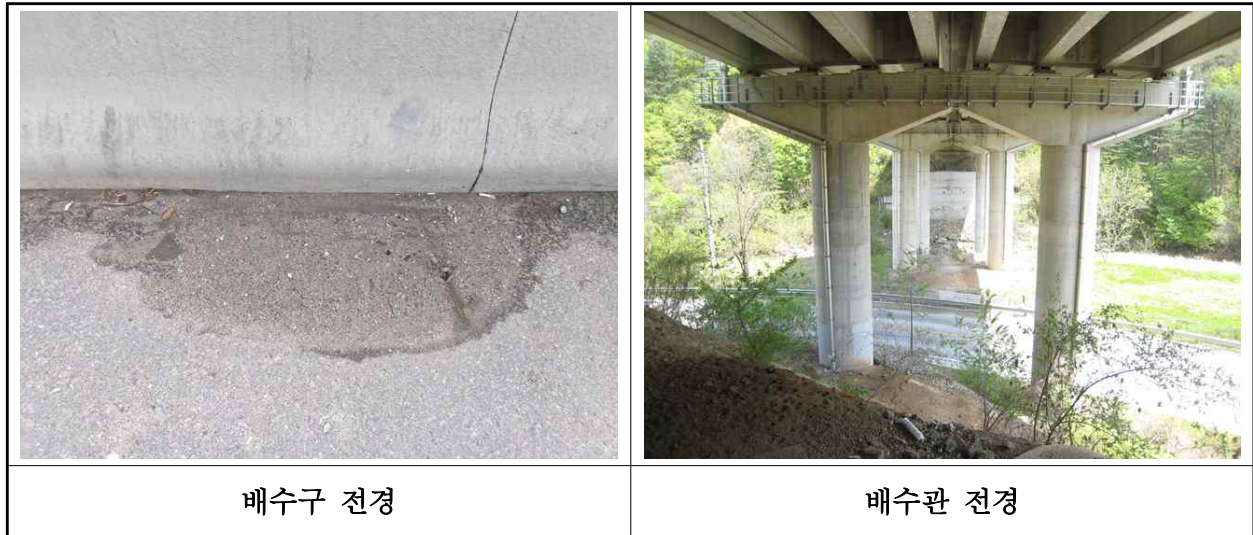
【사진 1.3.21】 배수시설 전경
