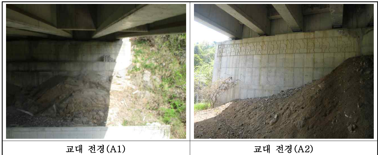
【사진 1.3.8】 교대 전경
