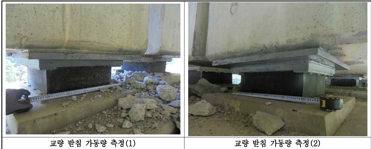
【사진 1.3.15】교량받침 이동량 측정
